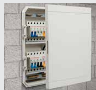
Instalação da Tampa
