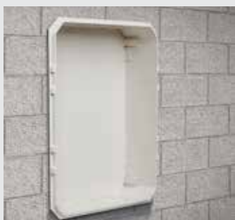
Instalação da Base
