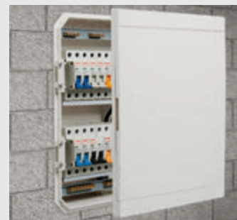
Instalação da Tampa
